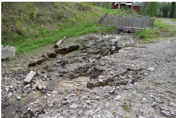
Nede ved veg for utsetting av båt i Glomma.
