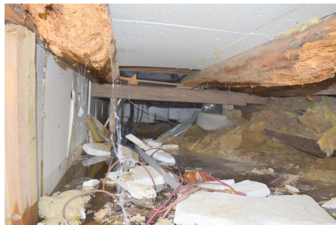
Fra krypkjeller under stue i gammel del av bygget.
