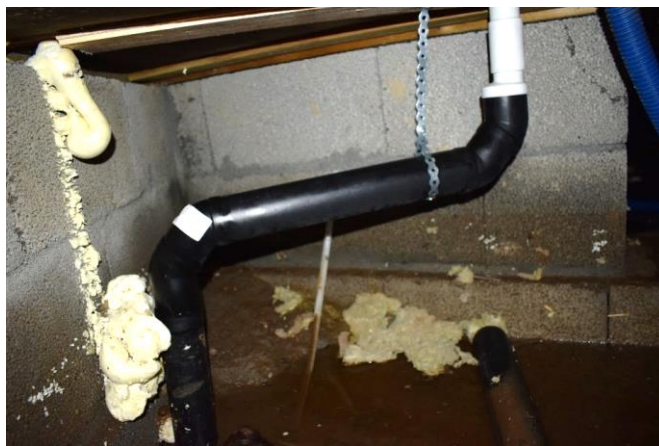
Fra krypkjeller under kjøkken (ny del).
