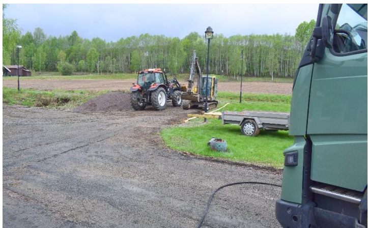
Oppryddingen er i gang. Her fra utskifting av masse ved nedkjøringen.
