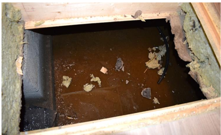
Fra krypkjeller under kjøkken (ny del).
