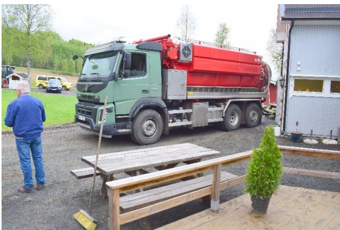
Renovasjonsbilen i ferd med å suge ut vann fra kjelleren.
