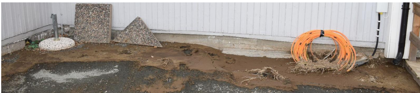
Foran kjøkkenvinduet på den gamle delen av bygget.
