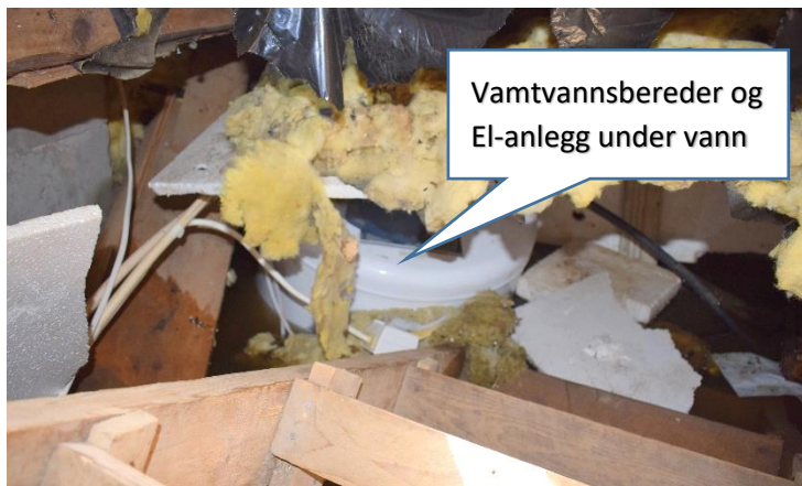
Fra kjellerrom under stue i gammel del av bygget.
